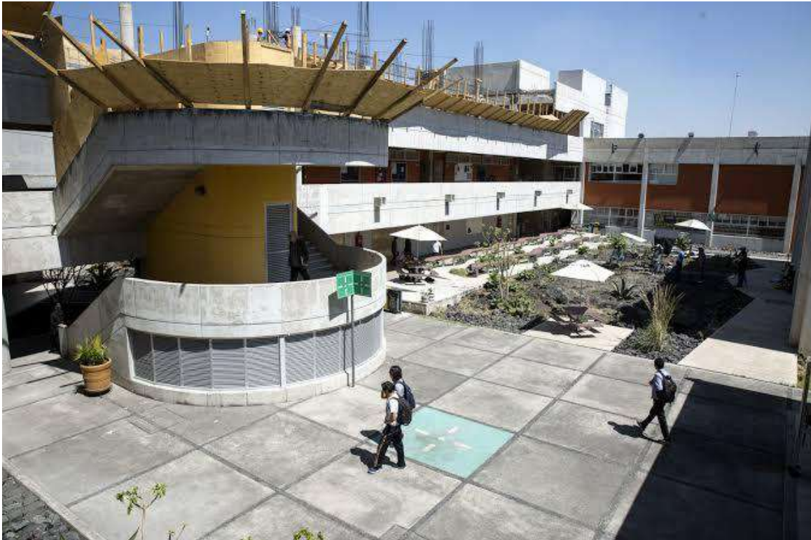
Ilustración 45. Obras en proceso
